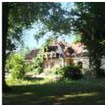
HoGast.I, Gasteigerhaus von Nordosten, DI013119, BSV
