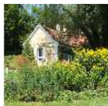
HoGast.I, Gasteigerhaus von Südosten mit Bauerngarten, DI013111, BSV
